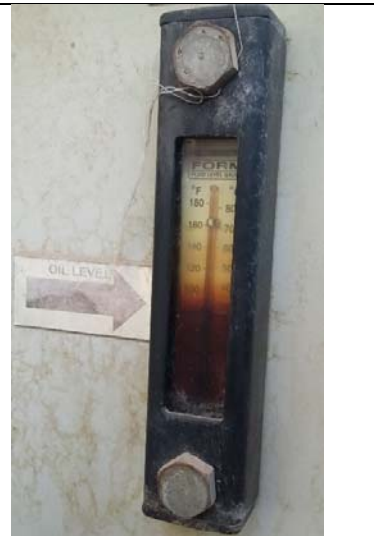
شکل ۱ - نشانگر های سطح روغن موجود که نشتی و کدر شدن شیشه در آن مشاهده می شود .
